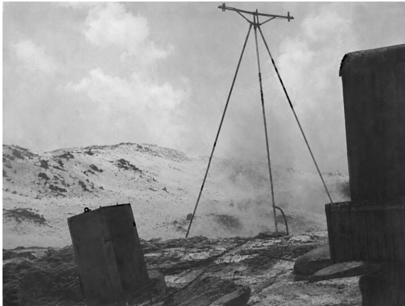
Historische Sprühvorrichtung von Hans Hangartner beim Einsatz in Indien im Juli 1988. Die einfache Konstruktion bestand aus mehreren hoch angeordneten Sprührohren und wurde zur feinen Zerstäubung des Wassers eingesetzt. [4]
