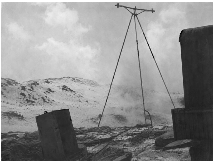
Dispositif de pulvérisation historique de Hans Hangartner lors de son intervention en Inde en juillet 1988. Cette construction simple se composait de plusieurs tubes de pulvérisation disposés en hauteur et servait à finement pulvériser l'eau.
